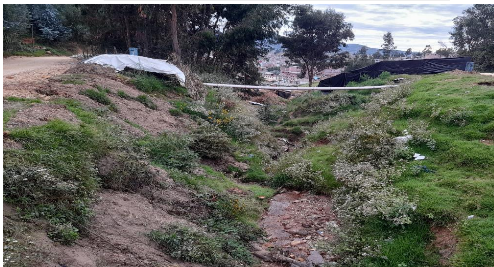
IMAGEN N°02: la Tucupina se encuentra colmatada, con maleza necesitando de mantenimiento para proteccion de la trocha carrozable
